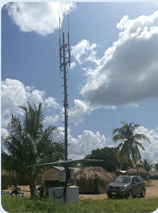
使用太阳能供电的加纳农网
